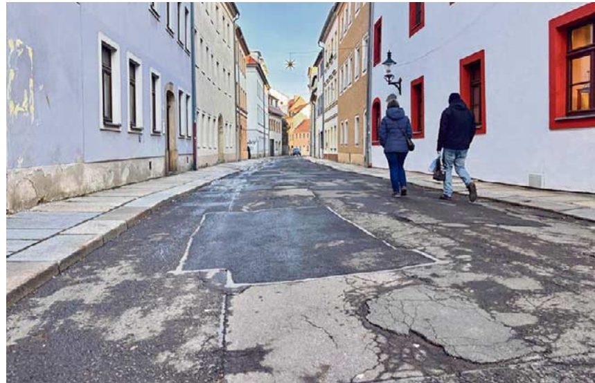
Die Moritzstraße wird ab April gebaut.
