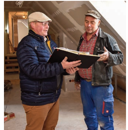
BTG-Chef Candy Münch (l.) bei einer Besprechung auf der Baustelle.
