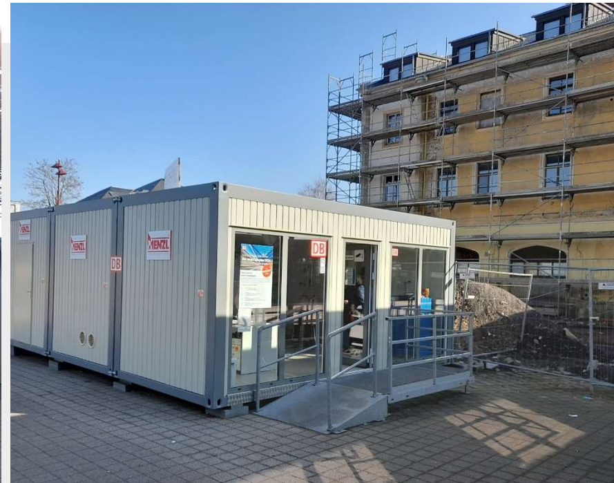
Reisezentrum und WC's für Bahnreisende als Interim-Containeranlage
